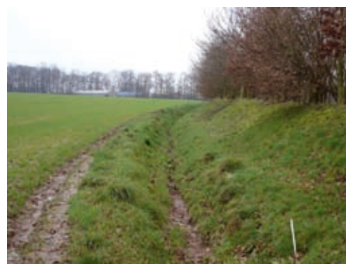
Fossé-talus de ceinturage collectant les ruissellements d'une parcelle cultivée et protégeant la route adjacente
