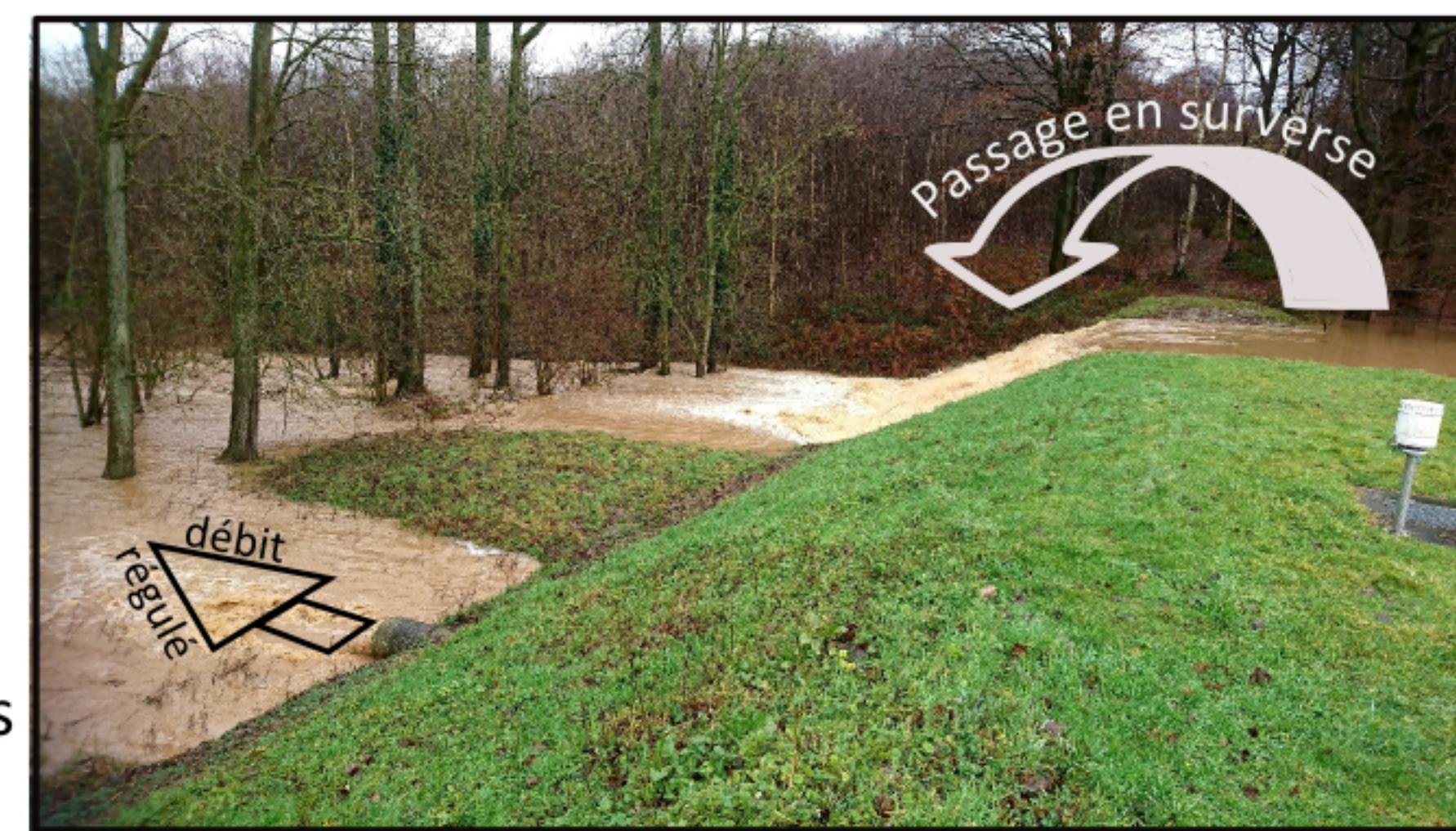
Ouvrage zone activités Autigny
