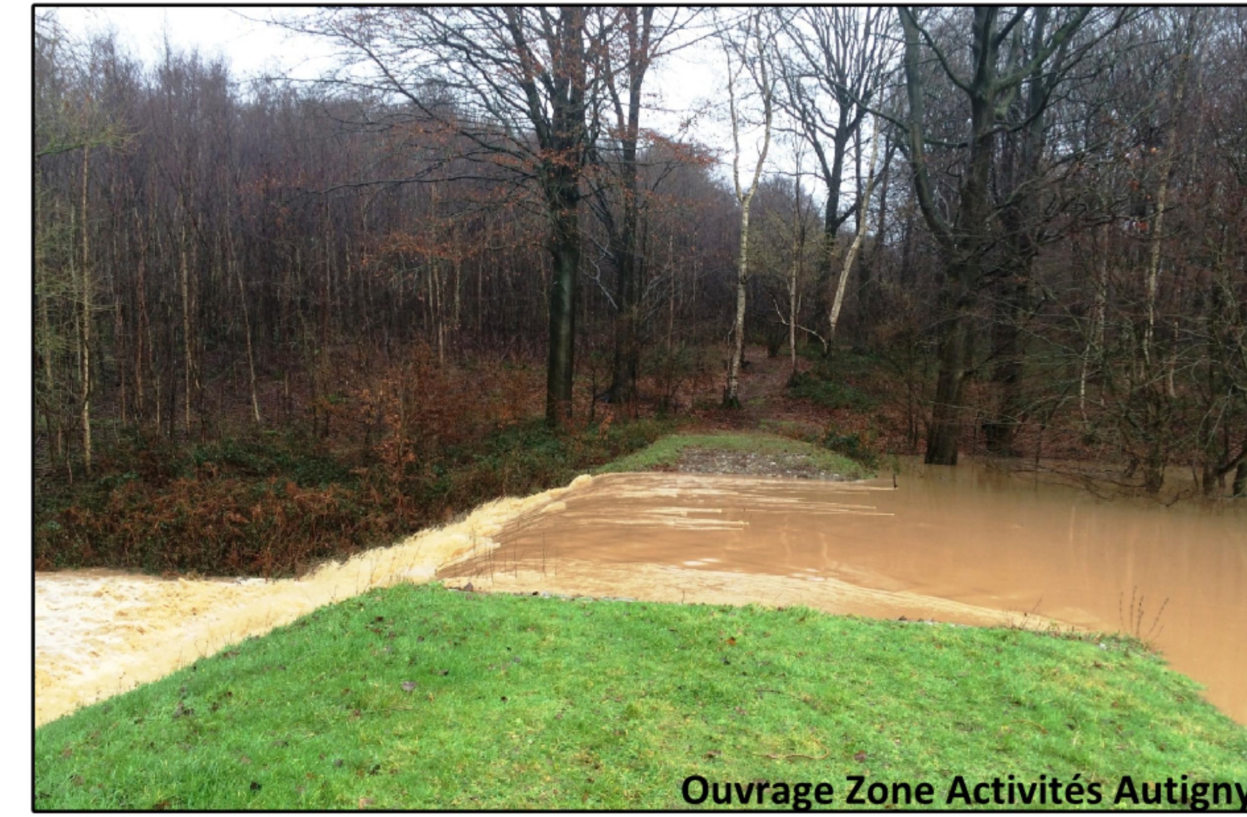
Ouvrage Zone Activités Autigny
