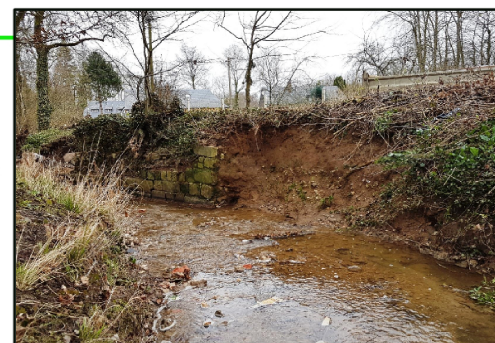
Erosion de berge à La Gaillarde
