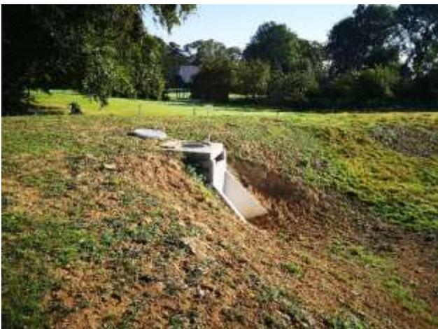
Sur ce dernier, l'ouvrage de fuite a été remplacé ainsi que le linéaire de canalisation dans la digue. Ce dernier a également été enrobé de béton.
