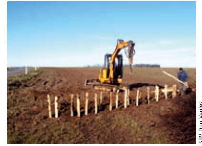
Battage des pieux
